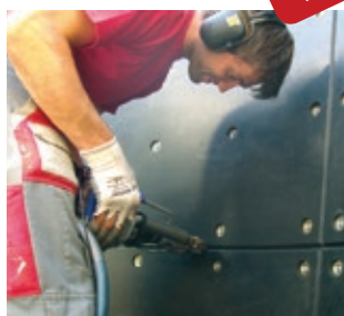
Auskleidung des Mischbehälters
